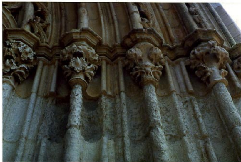
Abb. 28 Kapitelle der Gewändesäulchen am Westportal
