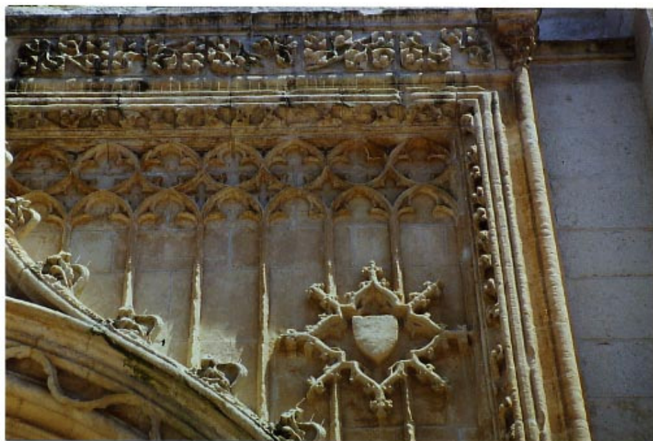
Abb. 29b Detail des Blendmaßwerkfeldes am Westportal
