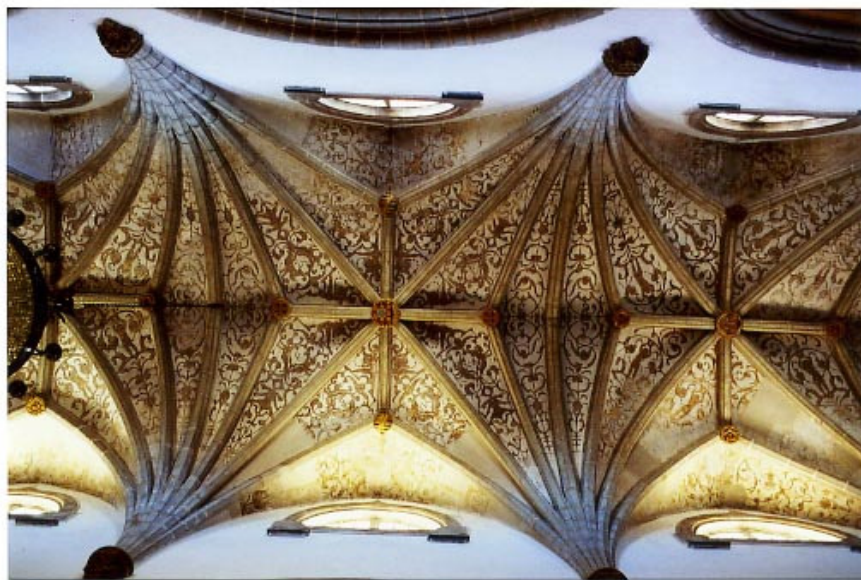
Abb. 78 Nossa Senhora da Assunção, Kathedrale in Elvas, Mittelschiffgewölbe
