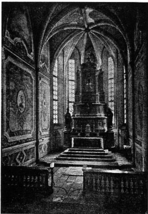
Abb. 34a Hauptkapelle vor der Restaurierung
