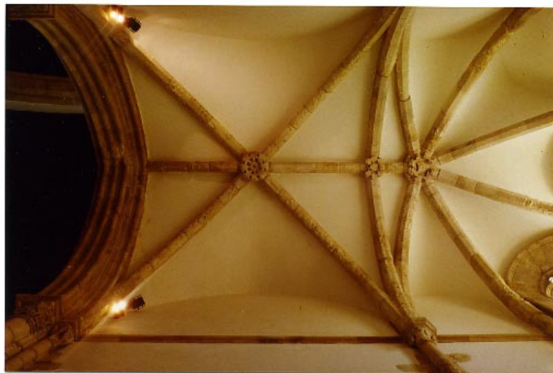
Abb. 22d Gewölbe der nördlichen Chorkapelle
