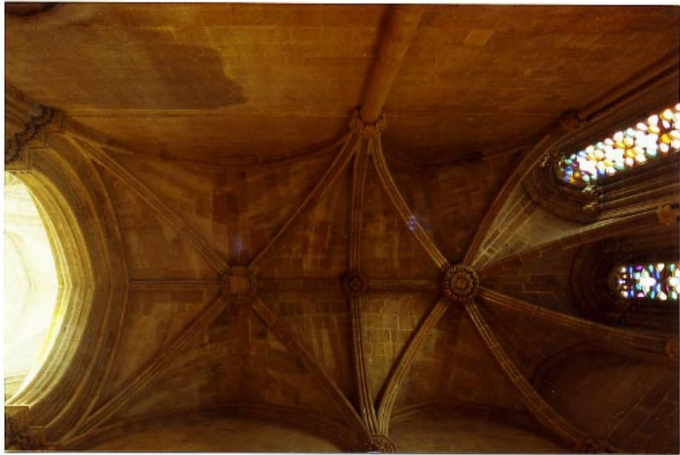
Abb. 69a Santa Maria da Vitória in Batalha, Gewölbe einer Nebenkapelle
