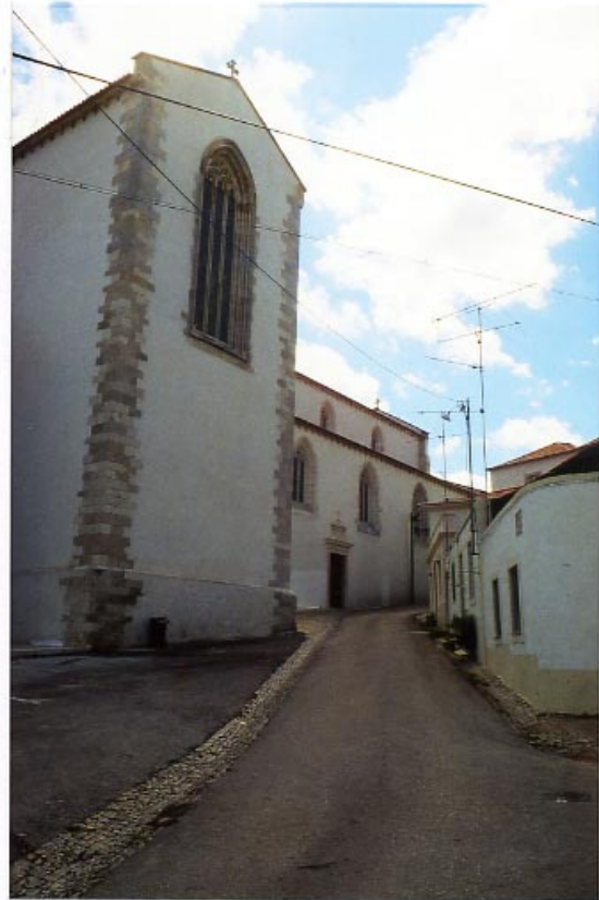
Abb. 17 Ansicht des Querhauses von Nordosten
