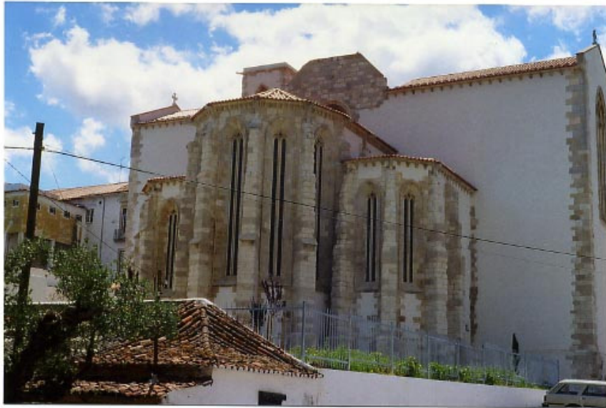
Abb. 14b Ansicht des Chores von Nordosten
