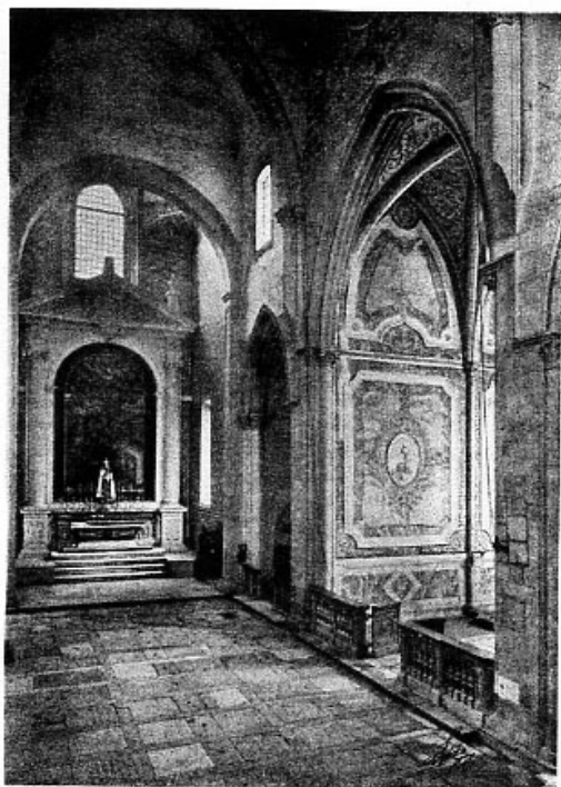
Abb. 35a Nördliches Querhaus vor der Restaurierung
