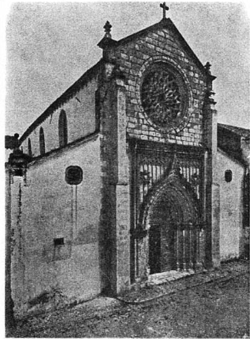
Abb. 37a Westfassade vor der Restaurierung
