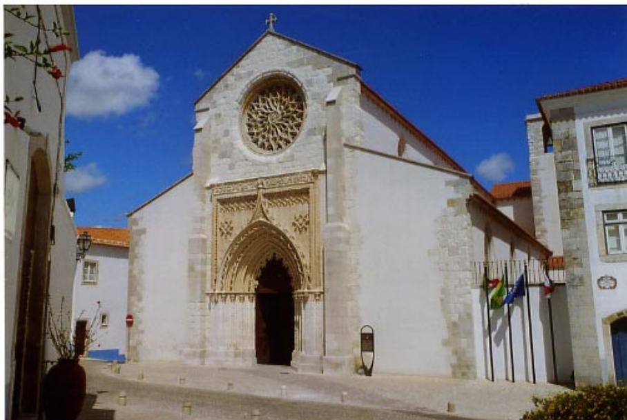
Abb. 20a Ansicht der Fassade von Südwesten
