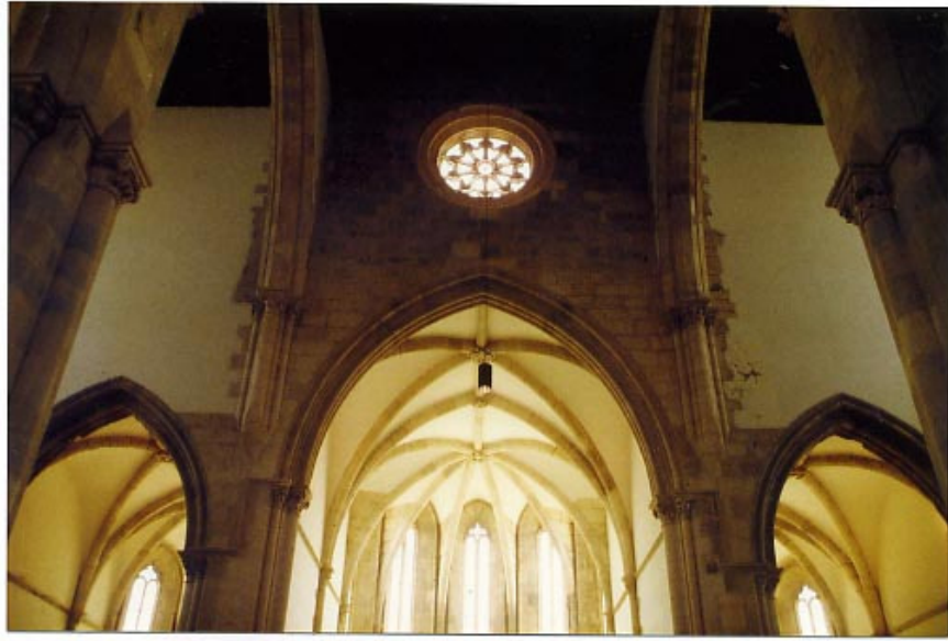
Abb. 24a Blick auf das Rundfenster und die Ostteile
