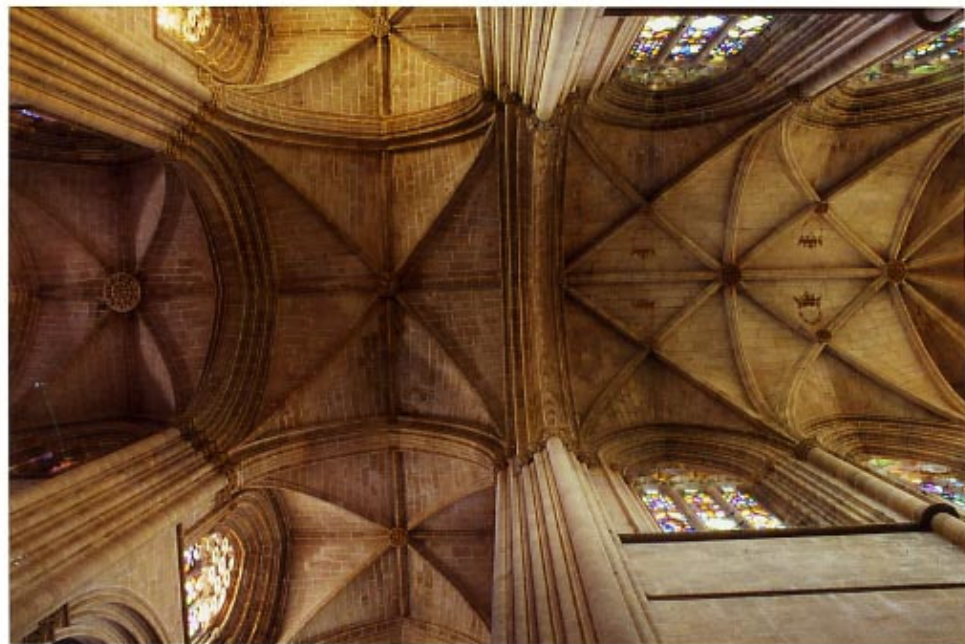
Abb. 69b Santa Maria da Vitória in Batalha, Gewölbe der Ostteile
